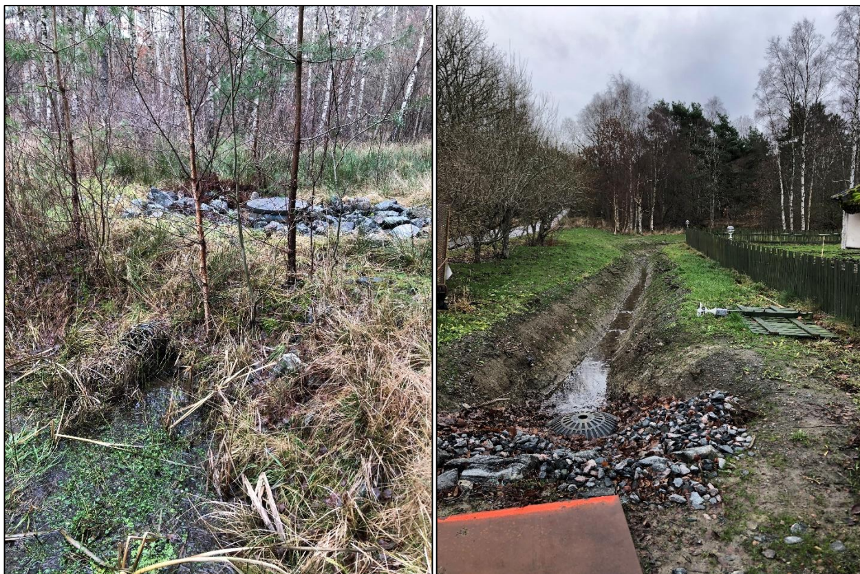
Figur 10. Anlagd våtmark i delavrinningsområde C och dike med anslutning till nedströms dagvattenledningen 600 BTG.
